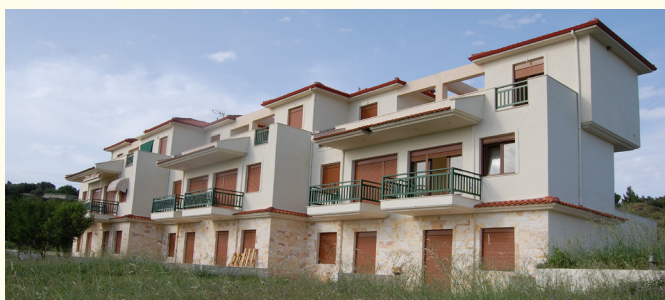
KUĆA POMME DE LA MER GPS N40.196108/E23.688767
