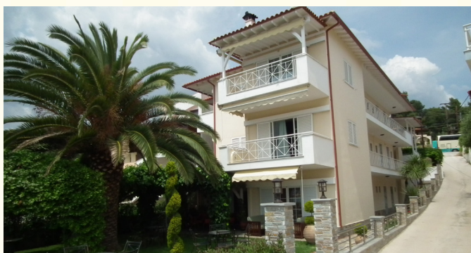
KUĆA PORTO PSAKOUDIA GPS N40.25943/E23.48847
