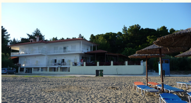
KUĆA ALEXANDRA GPS N 40.259388/E 23.490658
