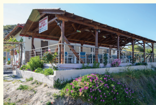
3. KUĆA LOFOS GPS N39.991620/E23.991992
